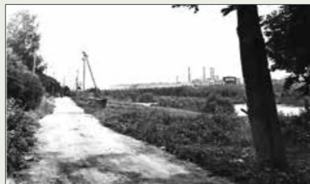
Вид на химкомбинат со стороны парка
